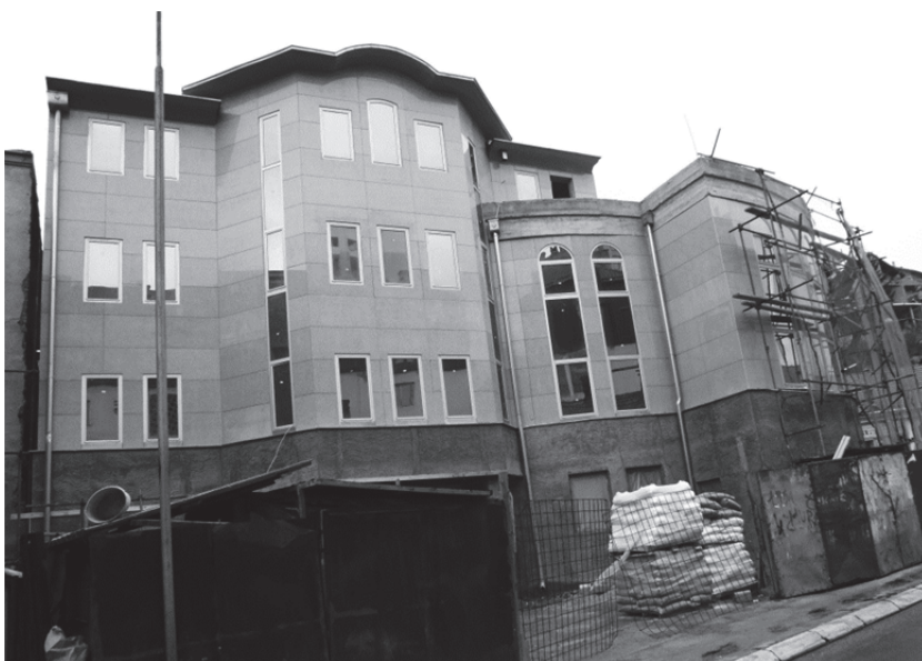
Нова зграда Историјског архива у току градње
